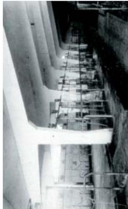
Fig. 16 El pajar en construcción, con el sistema Zollinger en forma de bóveda apuntada. SCHIRREN, 2001. 131
